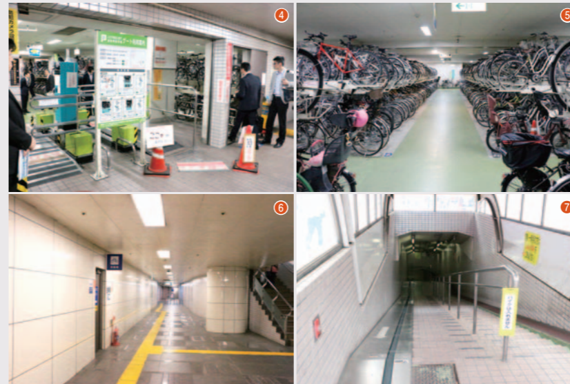
④北口地下自転車駐車場。自動ゲートは交通系電子マネーに対応。⑤2段式ラックにより1080台を収容。⑥駐輪後は地上へ出ずに地下通路で駅へ。⑦スロープはベルトコンベア付き
