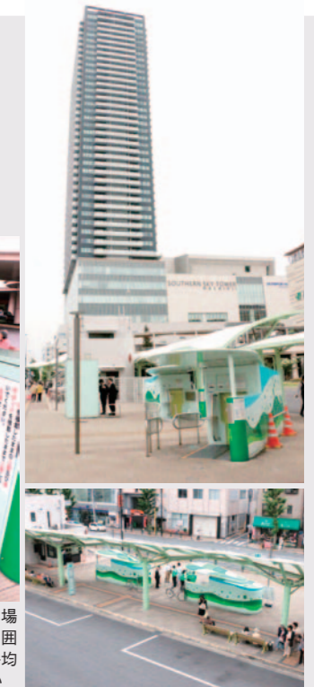
南口の地下タワー式自転車駐車場「エコサイクル」。ロータリーを囲むように6基設置されている。平均出庫時間は約13秒と非常に早い
